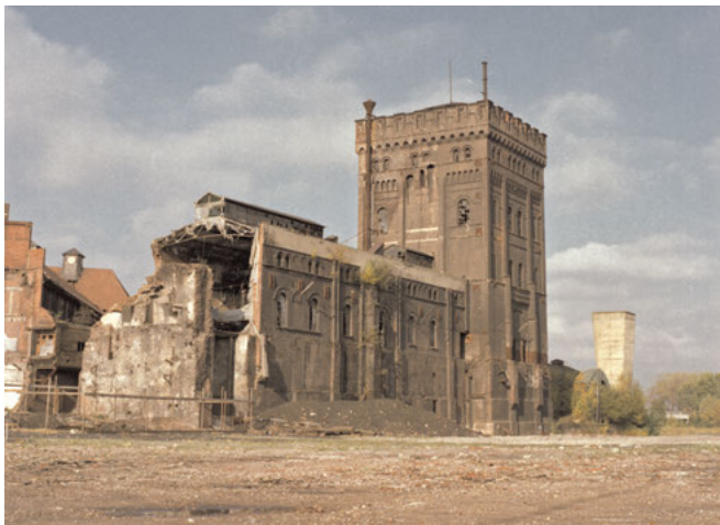
Abb. 28: Malakowturm der Zeche Hannover, 1981
