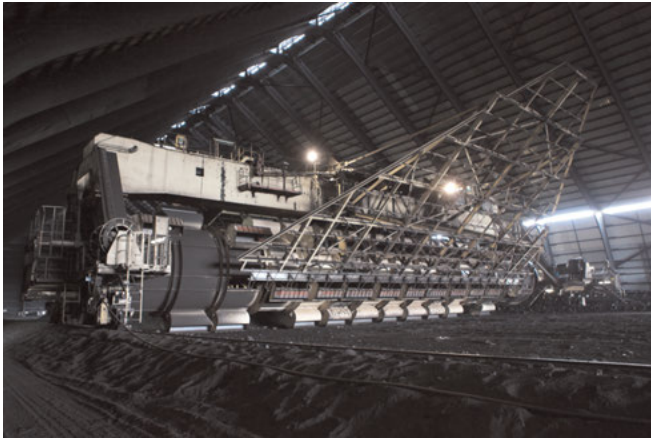
Abb. 22: Blick in die Rohkohlenmischhalle der Schachtanlage Auguste Victoria 3/7, Marl, 2012
