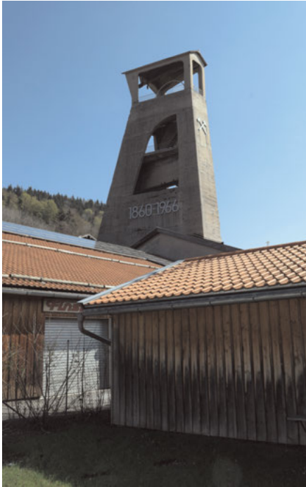
Abb. 31: Das ehemalige Fördergerüst des Klenze-Schachtes in Hausham
