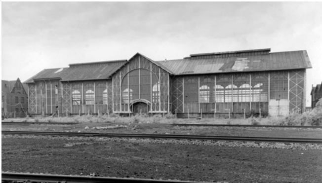
Abb. 29: Maschinenhaus der Zeche Zollern II/IV, 1982
