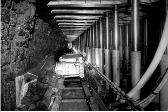
Abb. 21: Anschauungsbergwerk des DBM mit Walzenladerstreb in den 1960er-Jahren
