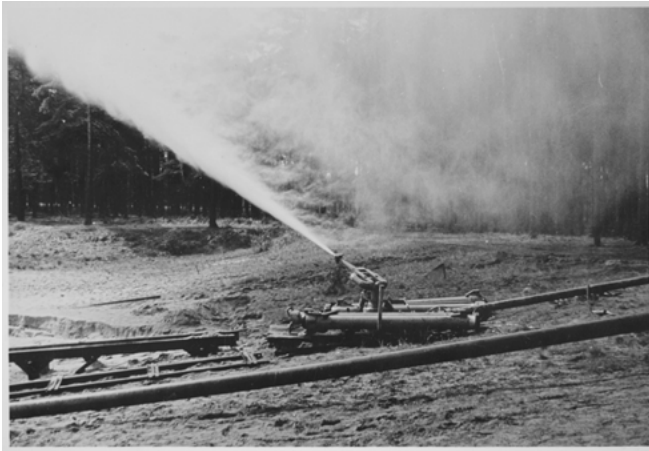
Abb. 6: Der Wasserwerfer bei Versuchen über Tage auf dem Gelände der Gewerkschaft Elwerath bei Celle, Juli 1962
