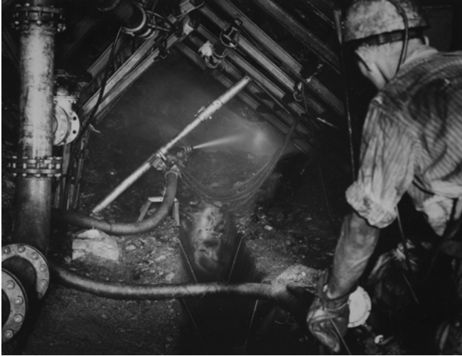
Abb. 13: Der Wasserwerfer der Bergbau-Forschung GmbH beim Auffahren einer Abbaustrecke auf der Zeche Carl Funke, o. D.
