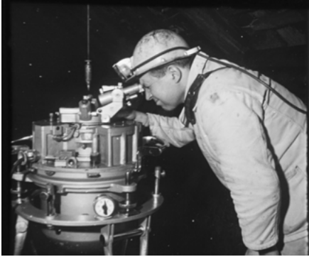
Abb. 10: Messung mit dem Meridianweiser unter Tage, ca. 1960
