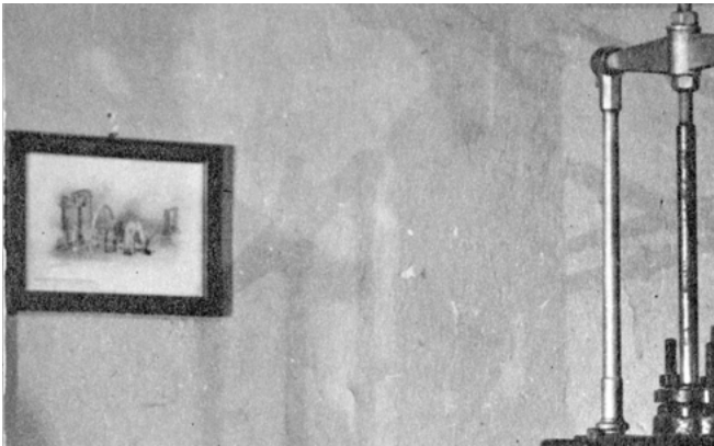
Abb. 4: Das vergrößerte Detail aus Abb. 2 zeigt die Darstellung der Jacobi, Haniel & Huyssen-Dampfmaschine an der Wand hinter der Dampfmaschine der Zeche Vereinigte Trappe
